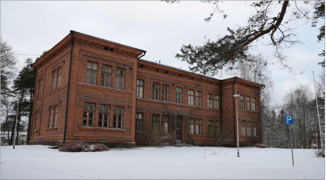
Sairaalarakennus kuvattuna lounaasta.
